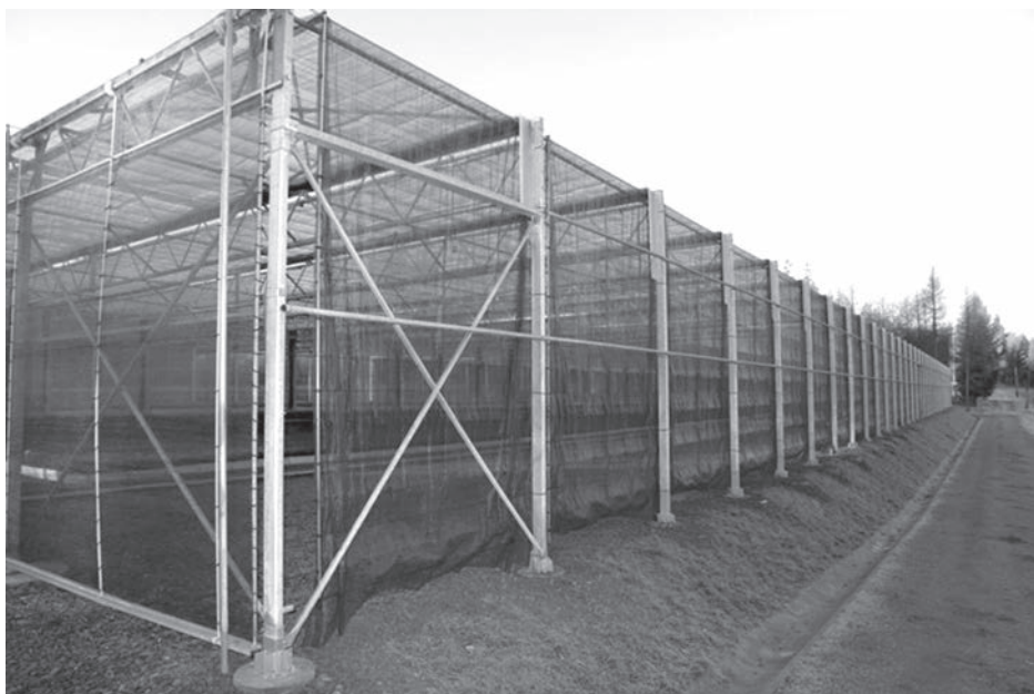
Rycina 11. Rampa z systemem cieniowników (fot. A. Młynarczyk)
